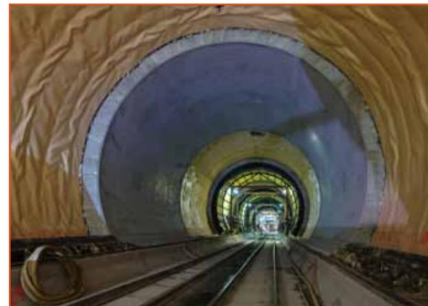
Die im Sprengvortrieb erstellten Bereiche der Tunnelröhre erhielten erst einen Überzug mit Spritzbeton (links), auf den dann eine wasserdichte Spezialfolie aufgebracht wird. Darunter sitzt dann die dauerhaft stützende bis zu 30 Zentimeter starke Betonschicht (oben)
