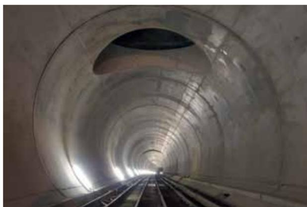
Der im Rohbau fertiggestellte Röhre mit den Gleisen der Grubenbahn. Wegen der hohen Geschwindigkeiten im Tunnel muss die Tunnelwand möglichst glatt sein
