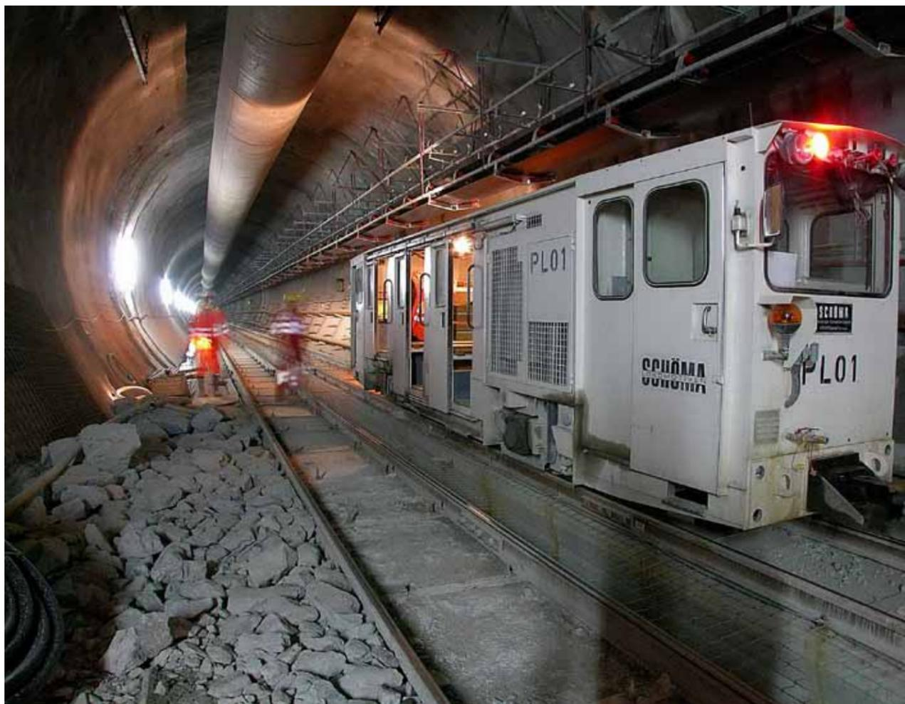
Grubenbahn auf Höhe von Amsteg. Diese Bahnen dienten während der Bauphase zum Transport von Mensch und Material
