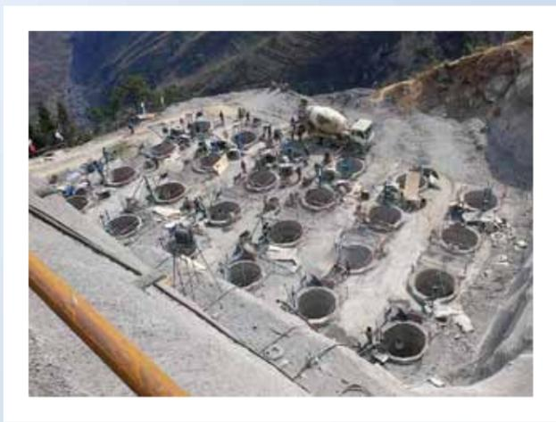
Weitgehend in Handarbeit treiben Arbeiter die Bohrungen für die Pfahlgründung des 269 Meter hohen Hauptpylons auf der Guizhou zugewandten Seite der Schlucht in die Tiefe
