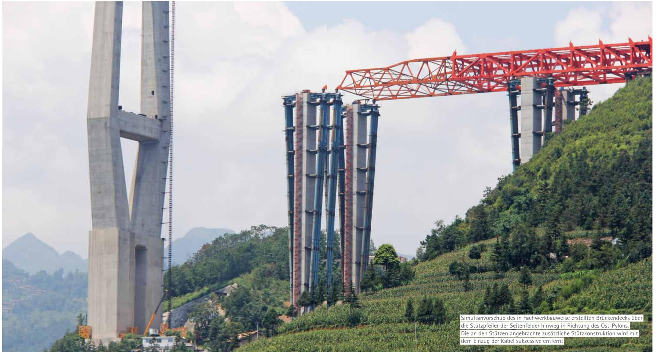
Simultanvorschub des in Fachwerkbauweise erstellten Brückendecks über die Stützpfeiler der Seitenfelder hinweg in Richtung des Ost-Pylons. Die an den Stützen angebrachte zusätzliche Stützkonstruktion wird mit dem Einzug der Kabel sukzessive entfernt
