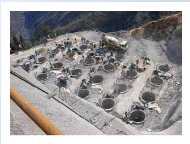
Weitgehend in Handarbeit treiben Arbeiter die Bohrungen für die Pfahlgründung des 269 Meter hohen Hauptpylons auf der Guizhou zugewandten Seite der Schlucht in die Tiefe
