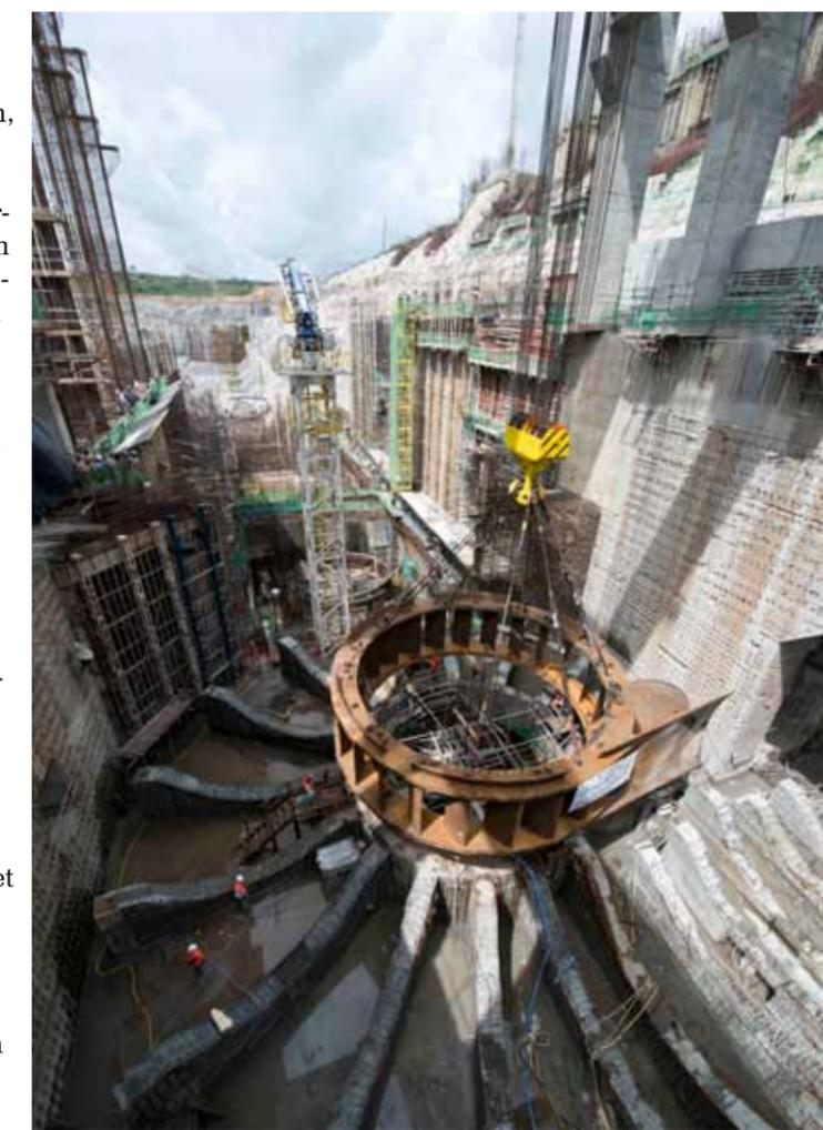
Das Innere des Turbinengehäuses mit den Leitschaufeln senkt sich auf das Fundament. Die konzentrisch angeordneten Stützstreben nehmen das schneckenförmige Gehäuse des Wasserzulaufs auf
