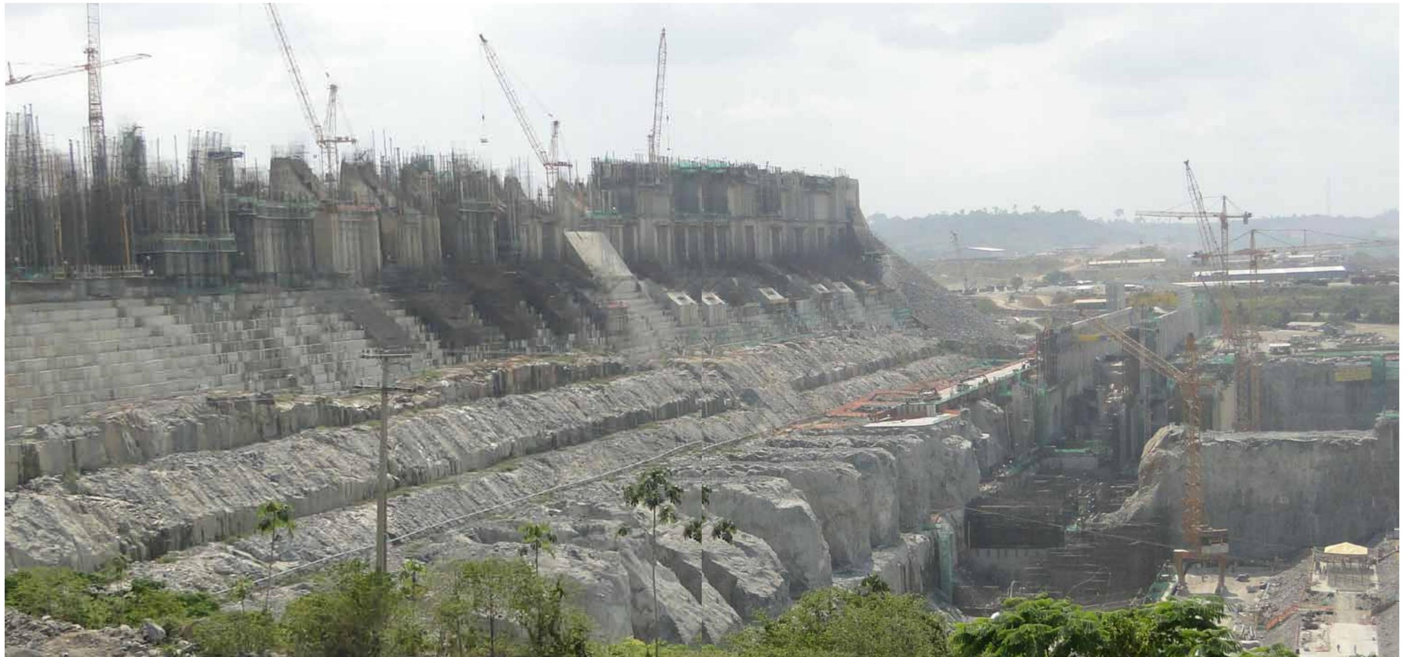
Das aus dem Fels gesprengte Fundament des Mega-Kraftwerks. Durch jeden der achtzehn Schächte führt später eines der mächtigen Druckrohre im Zulauf der Turbinen. Die unterste Stufe markiert das Niveau, auf dem das Wasser aus dem Auslassrohr der Turbine austritt. Der Höhenunterschied von der Dammkrone bis hier unten beträgt deutlich über 120 Meter
