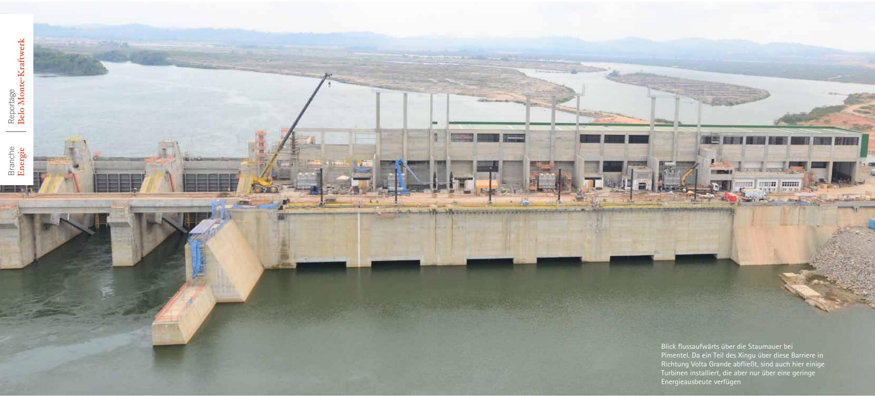
Blick flussaufwärts über die Staumauer bei Pimentel. Da ein Teil des Xingu über diese Barriere in Richtung Volta Grande abfließt, sind auch hier einige Turbinen installiert, die aber nur über eine geringe Energieausbeute verfügen
