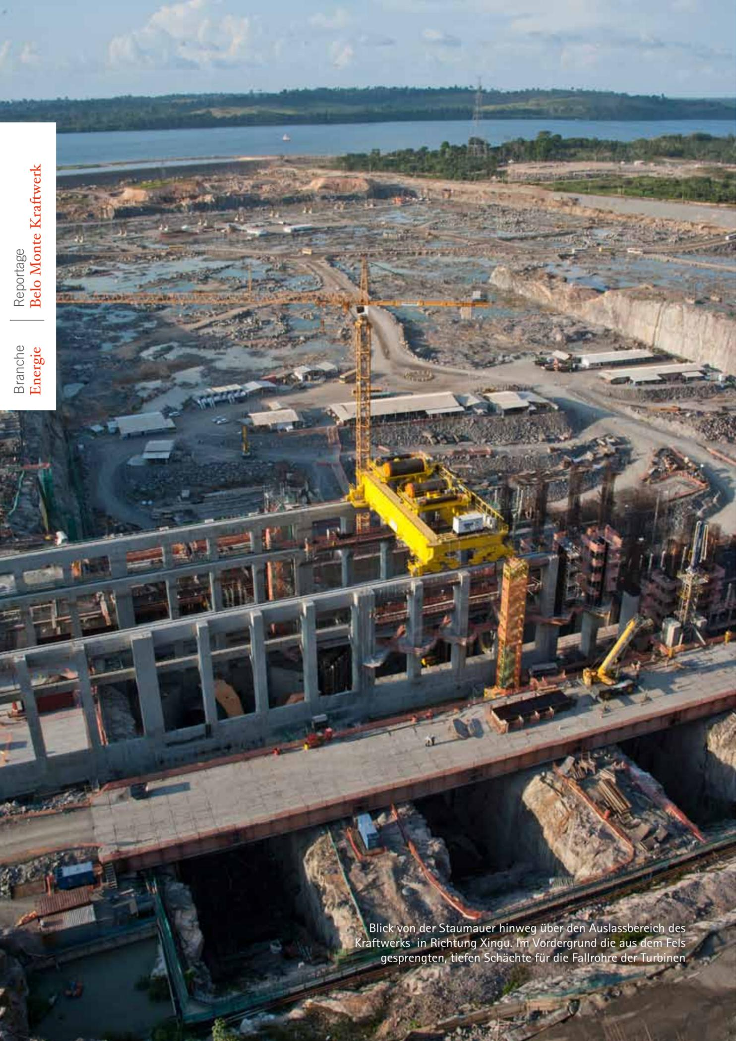
Blick von der Staumauer hinweg über den Auslassbereich des Kraftwerks in Richtung Xingu. Im Vordergrund die aus dem Fels gesprengten, tiefen Schächte für die Fallrohre der Turbinen
