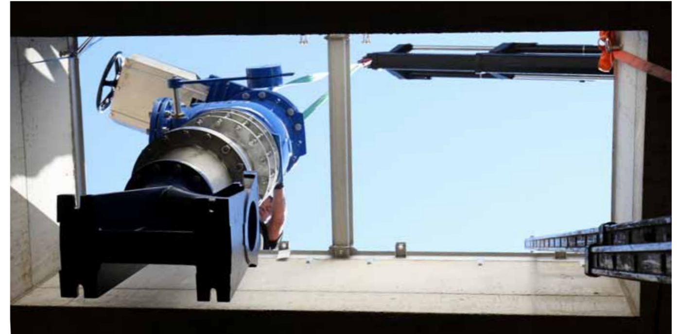
Da sich der Steg in der Mitte nicht ausbauen lässt, müssen die Aggregate mitsamt des weit ausladenden Absperrschiebers durch die schmale Öffnung bugsiiert werden
