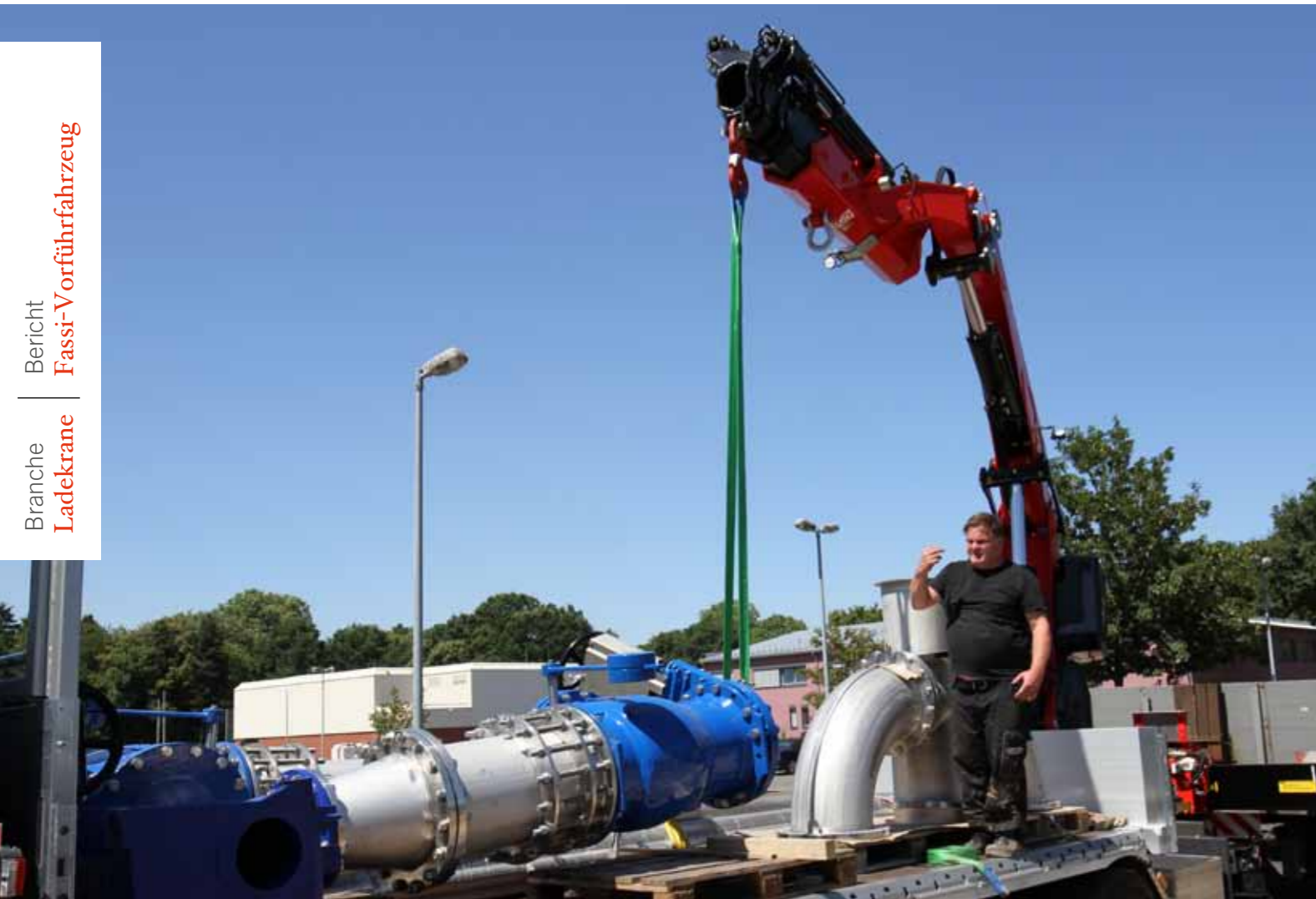
Über drei Meter hoch: Die Aggregate müssen in Einbaulage von der Ladefläche gehoben werden
