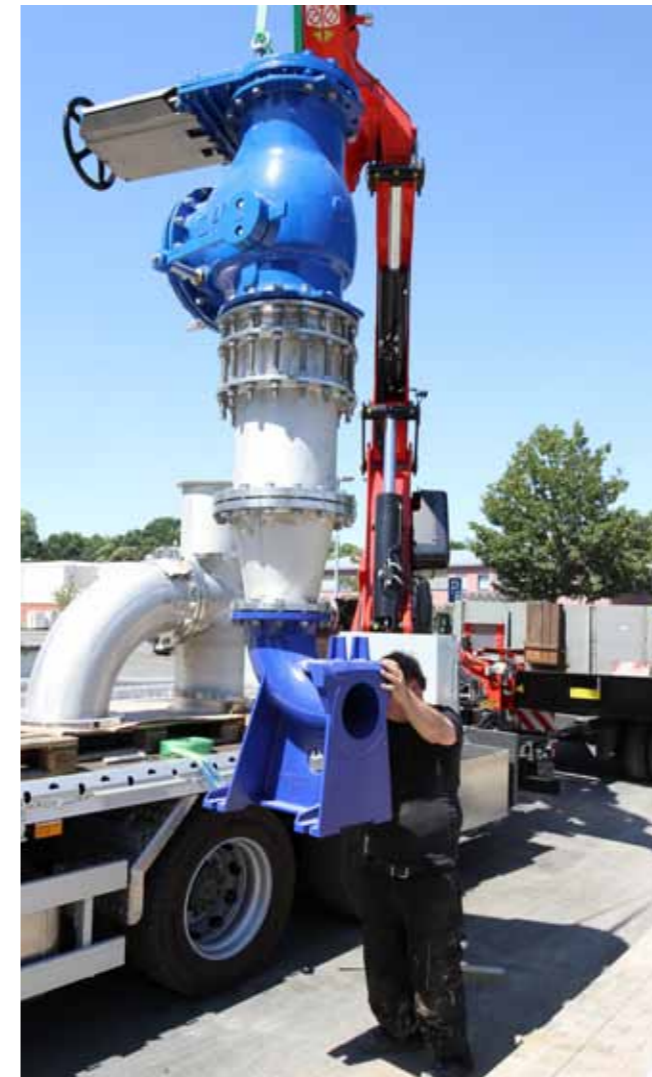
Nach dem Absetzen gilt es, die maximale Länge der Tragegurte zu nutzen, um hinunter in den Schacht zu reichen
