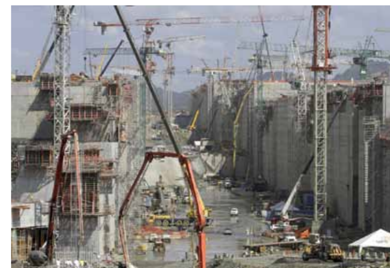
Ohne Wasser beinahe noch eindrucksvoller: Die gigantischen Kammern der Gatún-Schleuse. Im Bild links wird gerade eines der Schleusentore eingebaut
