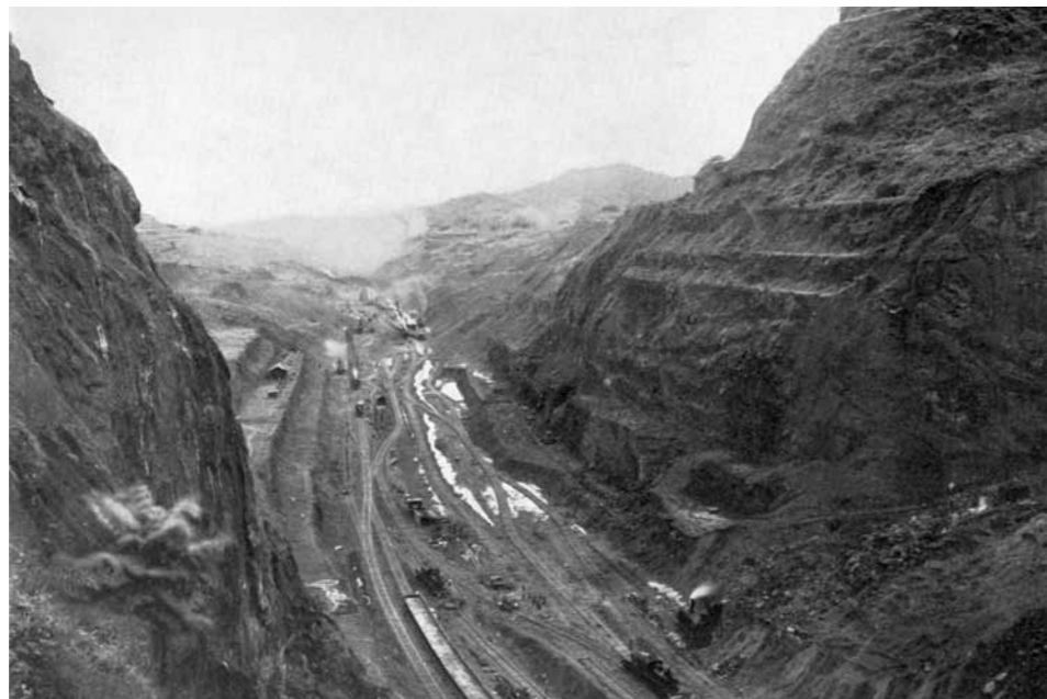
Durchstich durch die kontinentale Wasserscheide: Der rund 13 Kilometer lange Culebra Cut erforderte Erdbewegungen bislang ungeahnten Ausmaßes. Rechts unten eine historische Aufnahme der Bauarbeiten an etwa der gleichen Stelle
