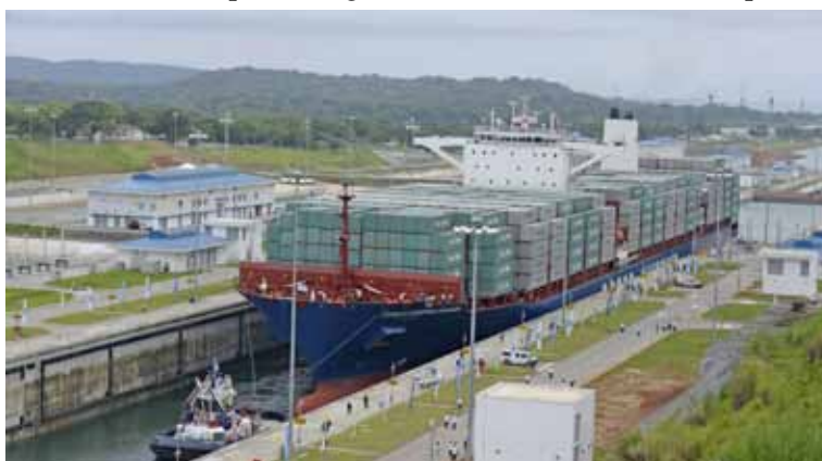
Inbetriebnahme der Erweiterung des Panamakanals bei Abfertigung der Cosco Shopping Panama an der neuen Gatún-Schleuse
