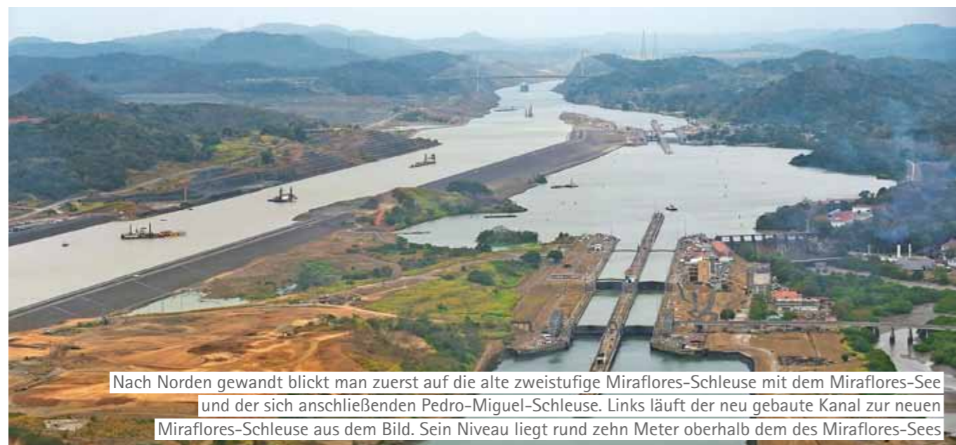
Blick in Richtung Pazifik mit der neuen dreistufigen Miraflores-Schleuse im Vordergrund. Am oberen Bildrand kommt die Puente de las Américas in Sicht
