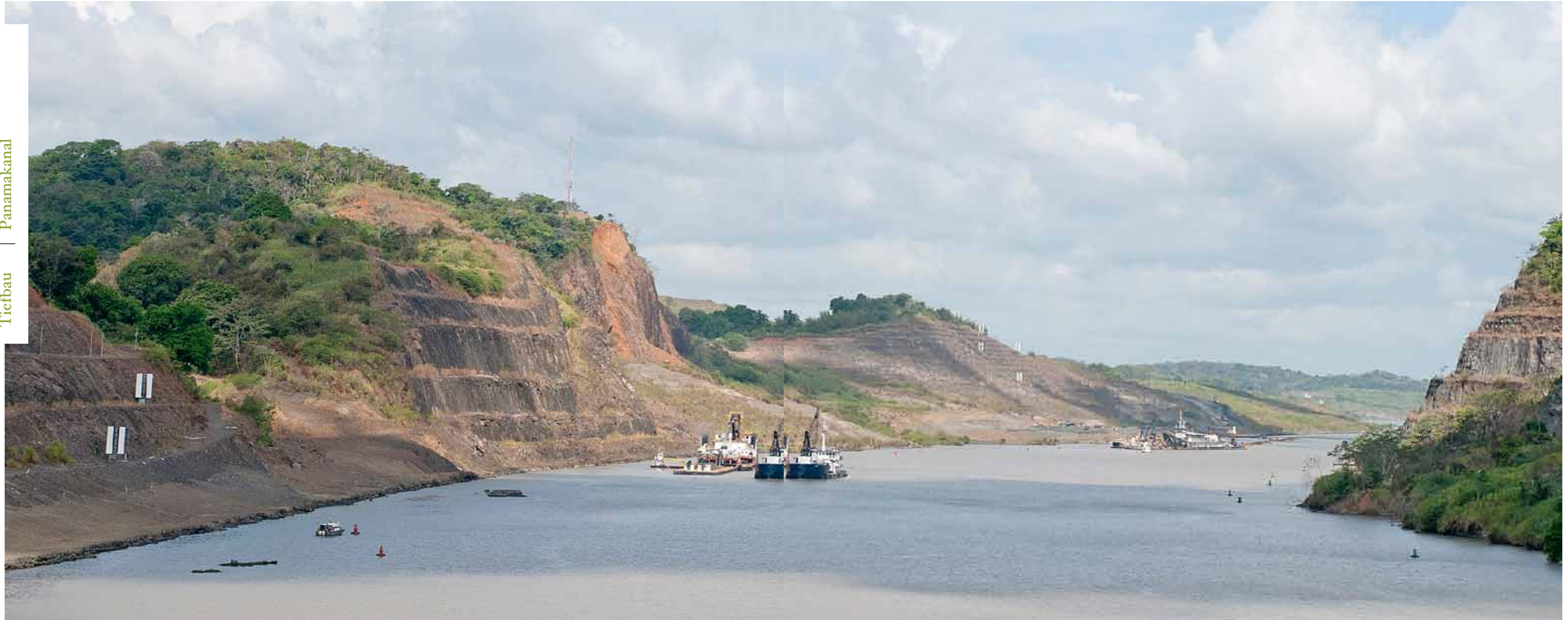
Durchstich durch die kontinentale Wasserscheide: Der rund 13 Kilometer lange Culebra Cut erforderte Erdbewegungen bislang ungeahnten Ausmaßes. Rechts unten eine historische Aufnahme der Bauarbeiten an etwa der gleichen Stelle
