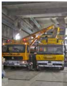
Wegen des engen Raums über dem Getriebe mussten die Mobil-Montagekräne auf den Millimeter genau positioniert werden
